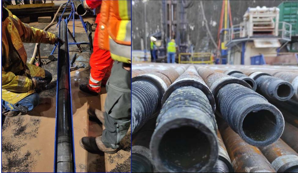
**Eindrücke aus der aktuellen Bohrkampagne, links der gesuchte Kupferschiefer frisch aus dem Bohrloch, rechts die notwendigen Stahlrohre mit Bohrgerät im Hintergrund**
