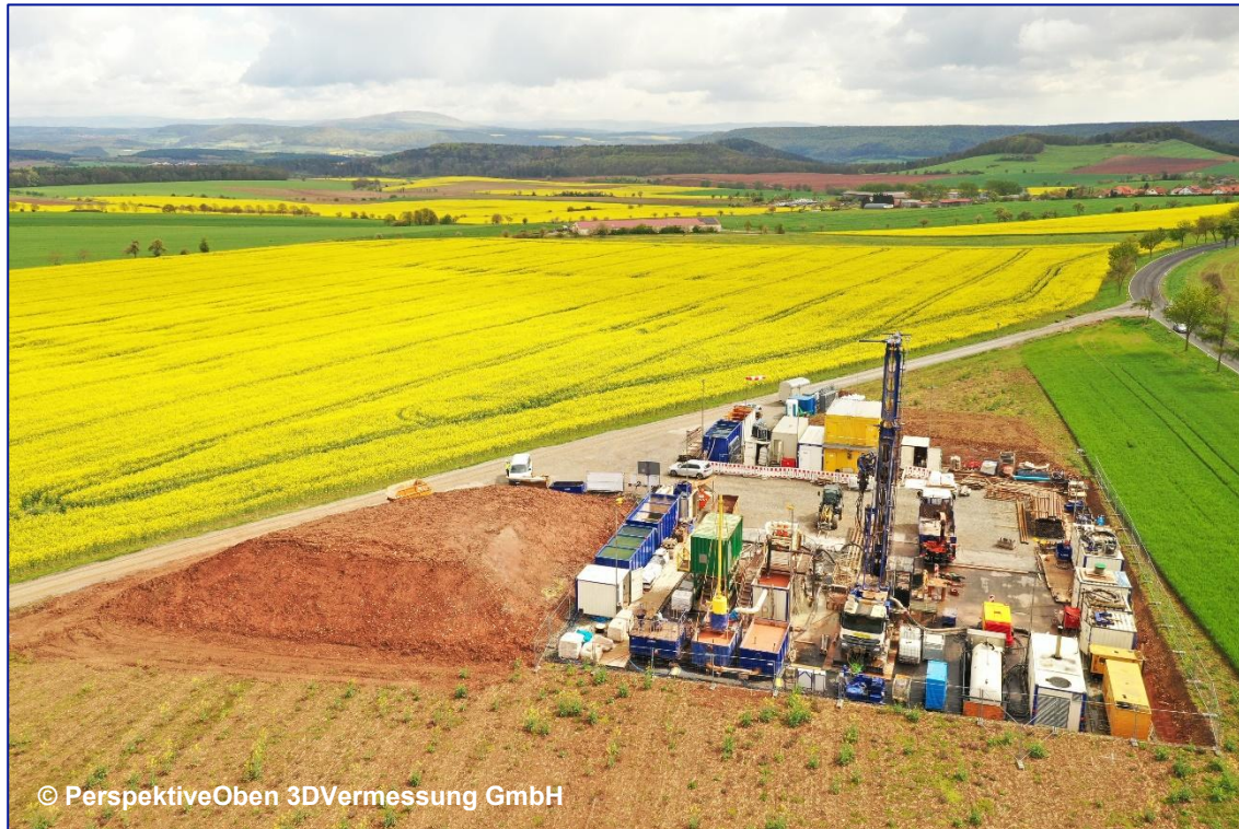
Bohrung LWS Cu Steu 1/23 (April 2024)
