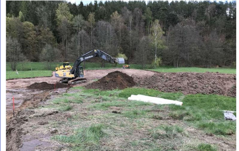
Der entstehende Bohrplatz bei Schwallungen. Foto: /Peter Pilz
