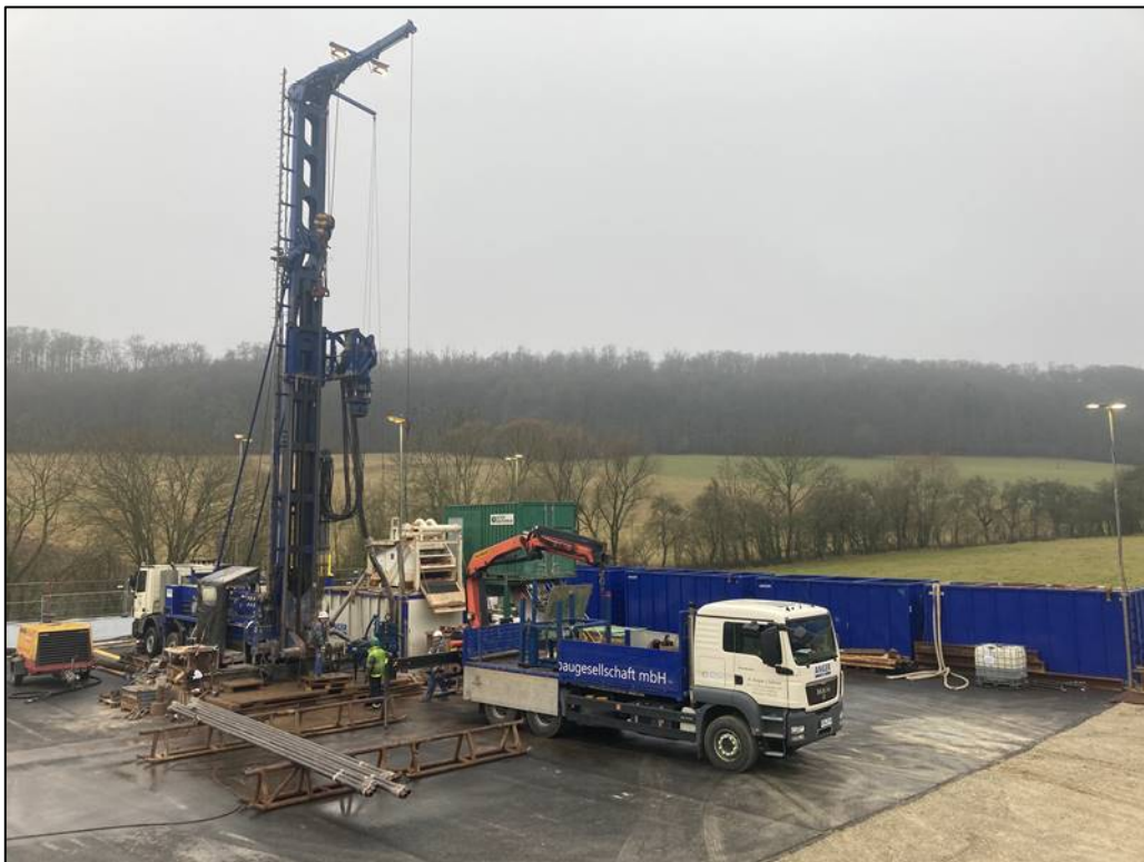
Abb. 1: Bohrplatz einer Erkundungsbohrung mit Bohrgerät und angeschlossener technischer Infrastruktur
