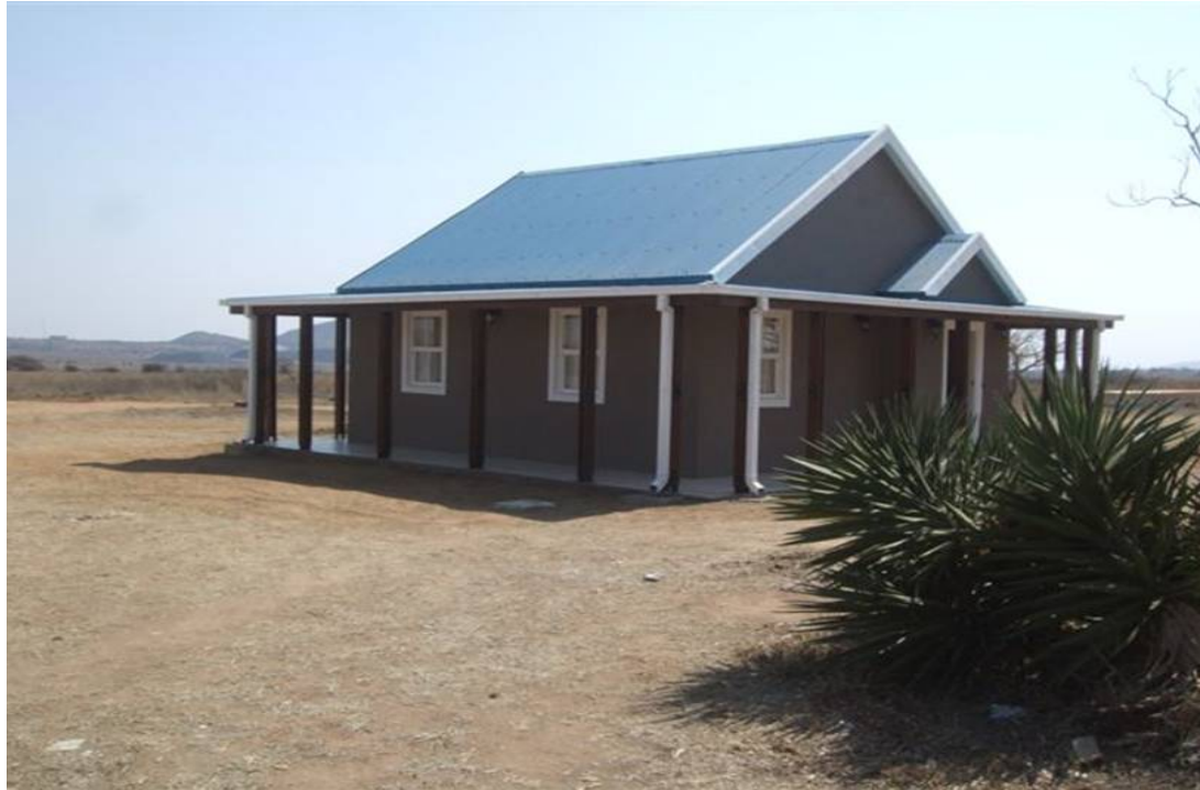
46 m 2 Slag House
