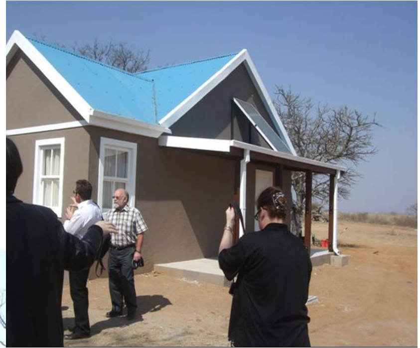
85 m 2 Slag House
